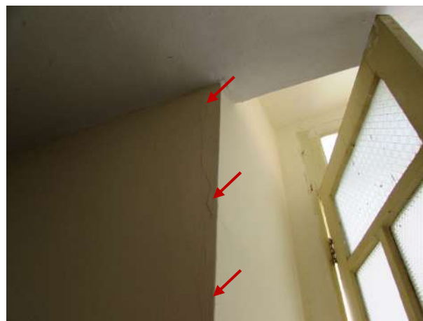
Figura 230 – Detalhe da parede adjacente ao acesso trincada
