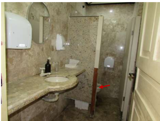
Figura 263 - Detalhe da divisória de madeira banheiro unissex danificada
