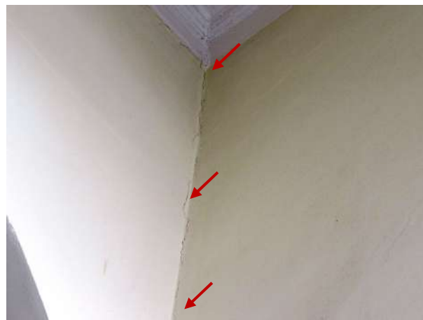
Figura 209 - Detalhe da parede trincada na interface ortogonal
