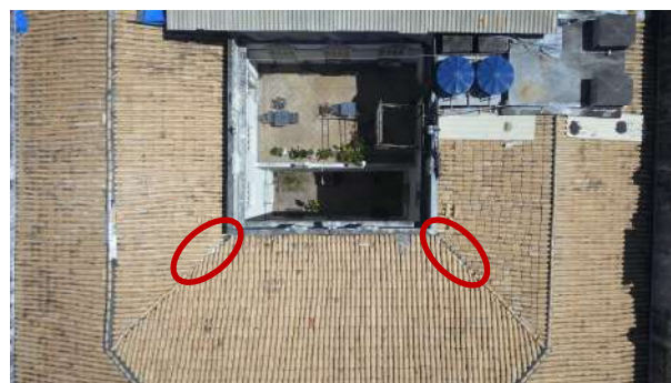
Figura 41 - Detalhe das cumieiras com parte das telhas ausentes
