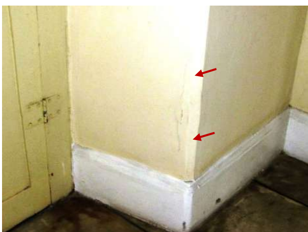
Figura 252 – Detalhe da trinca na zona inferior da parede
