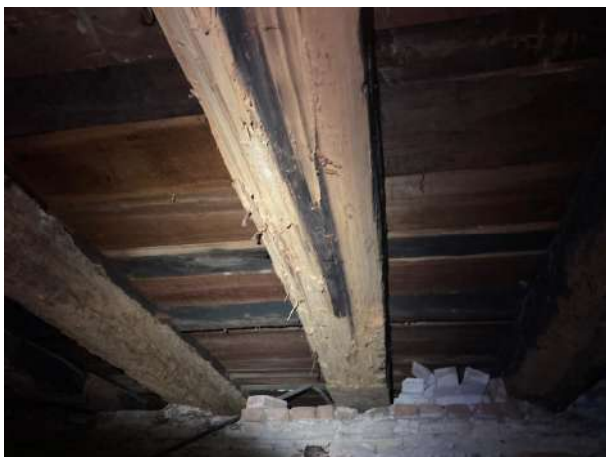
Figura 166 – Detalhe das vigas de madeira do piso do pavimento superior degradadas, com perda considerável das seções resistentes
