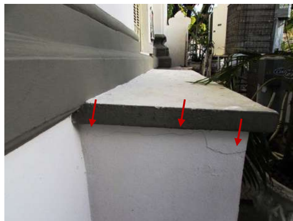
Figura 268 – Detalhe da parede do abrigo trincada
