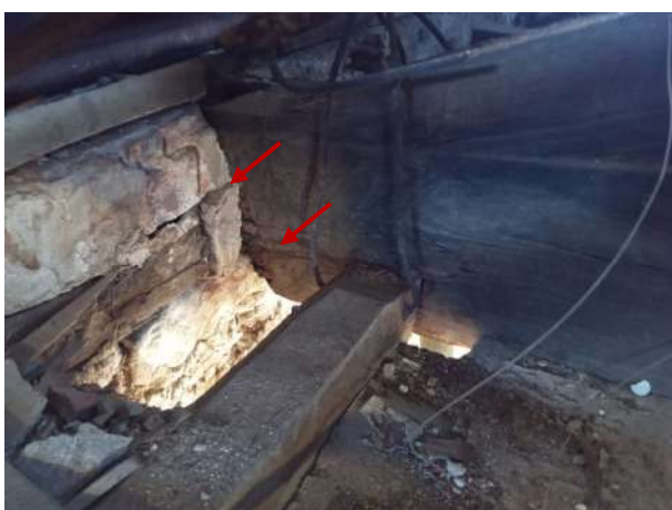
Figura 58 - Detalhe da cabeceira da tesoura apoiada na parede em zona onde o forro inferior foi danificado
