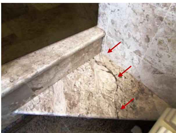
Figura 115 – Detalhe do degrau de mármore rachado
