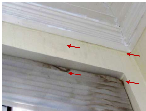
Figura 185 - Detalhe da parede, região sobre a janela, fissurada e com infiltração
