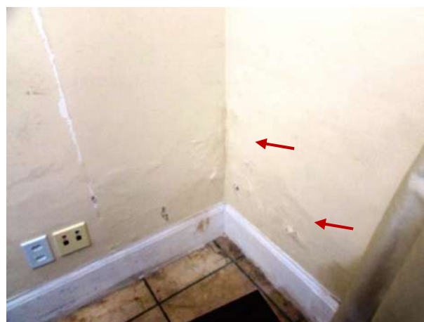
Figura 191 - Detalhe da parede com umidade e desprendimento do substrato e pintura
