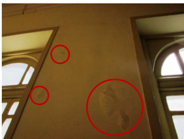
Figura 97 – Detalhe da parede com incidência de umidade e desprendimento do substrato
