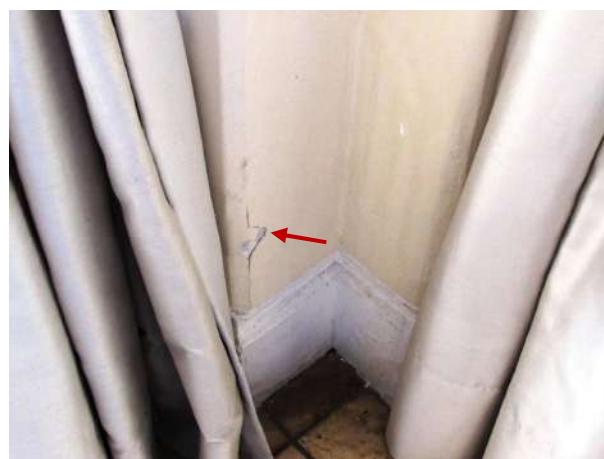
Figura 183 -Detalhe da parede com umidade e desprendimento do substrato e pintura
