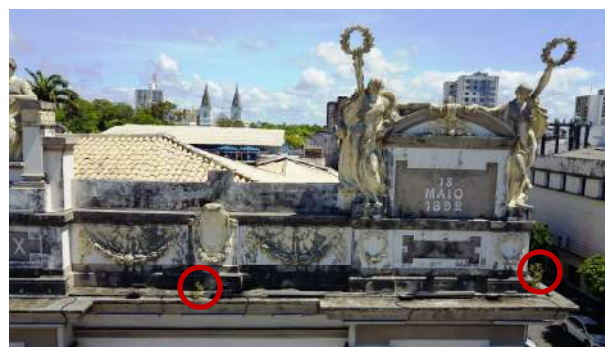
Figura 11 - Detalhe da platibanda e marquise com acúmulo de matéria orgânica (generalizado) e crescimento de vegetação (círculos)
