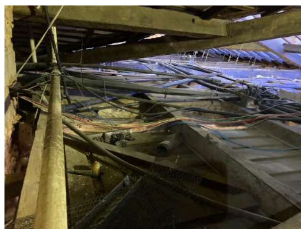
Figura 59 - Vista dos circuitos elétricos instalados diretamente no forro de madeira
