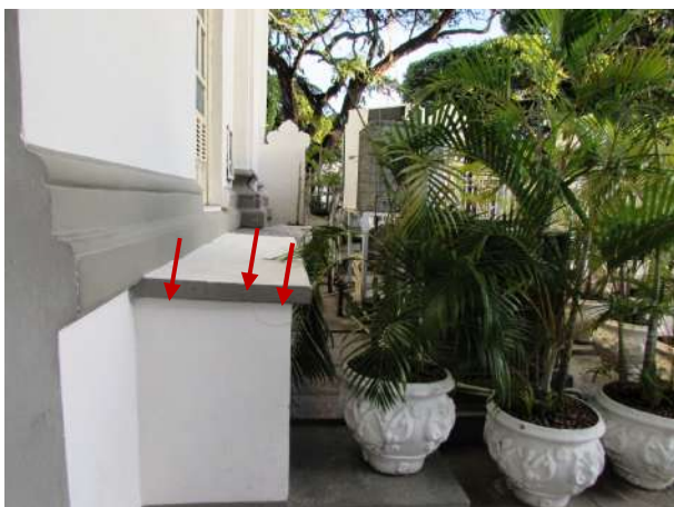
Figura 267 – Vista geral da zona sobre o reservatório inferior com destaque para parede do abrigo trincada
