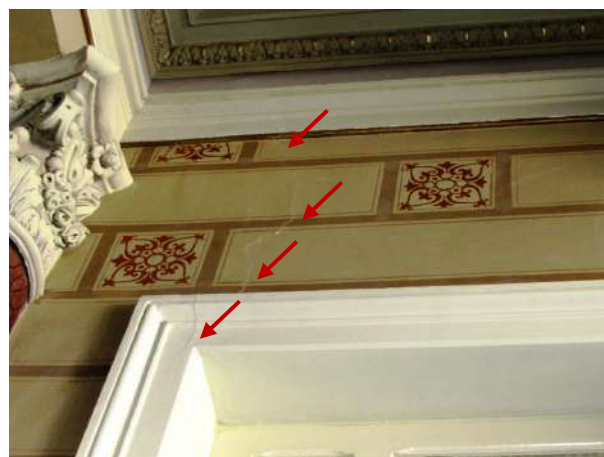
Figura 228 - Detalhe da parede, região sobre a porta, fissurada
