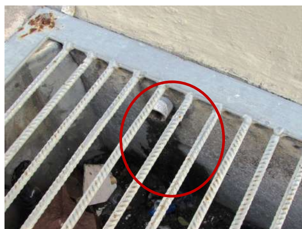
Figura 280 – Detalhe do dreno em operação e matéria orgânica no seu entorno
