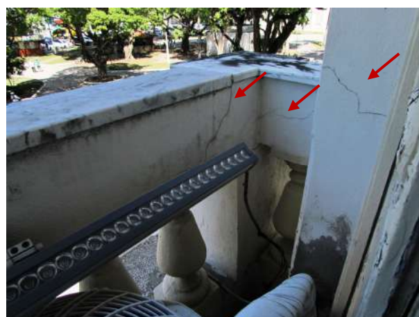
Figura 92 – Detalhe da sacada trincada
