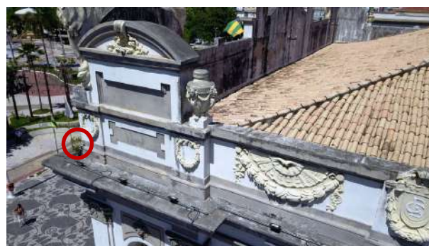
Figura 37 - Detalhe da platibanda e marquise com acúmulo de matéria orgânica (generalizado) e crescimento de vegetação (círculo)
