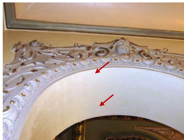
Figura 72 – Detalhe da microfissura no acesso
