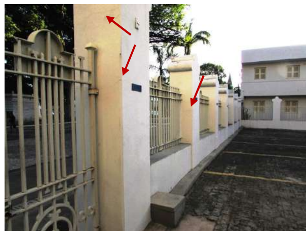
Figura 278 – Detalhe das colunas perimetrais trincadas
