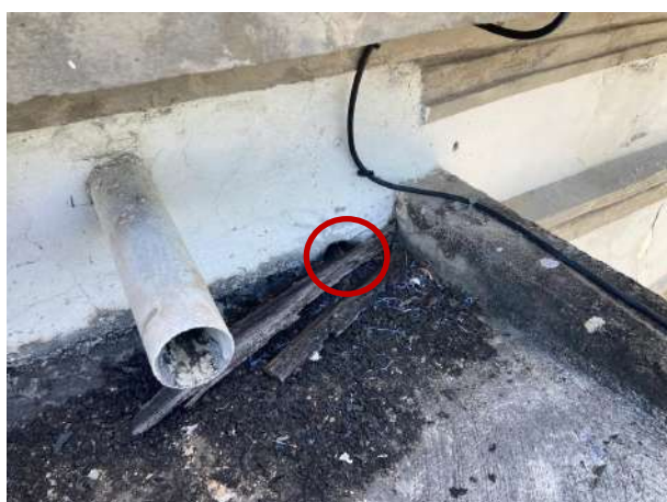
Figura 46 – Detalhe do dreno com a seção significativamente bloqueada por sujeiras e ausência de declividade para escoamento
