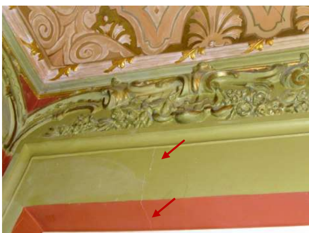
Figura 69 – Detalhe da fissura na janela do salão nobre
