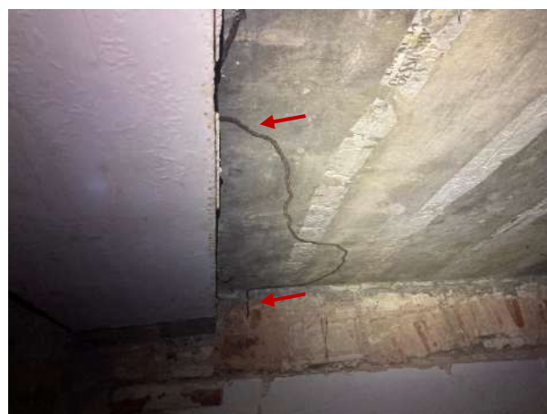
Figura 175 - Detalhe da galeria de cupins aderida ao concreto
