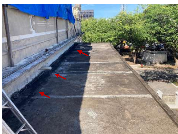
Figura 44 – Detalhe da laje superior do terraço coberto com impermeabilização ineficiente, acúmulo de sujeiras próximo aos drenos (setas) e declividade deficiente
