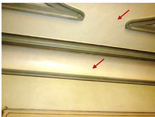
Figura 73 – Microfissuras e incidência de umidade no forro leste
