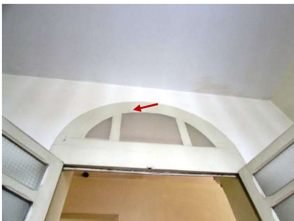
Figura 146 - Detalhe da parede, região sobre a porta, microfissurada
