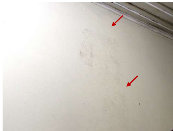
Figura 221 - Detalhe da parede leste com presença de mofo
