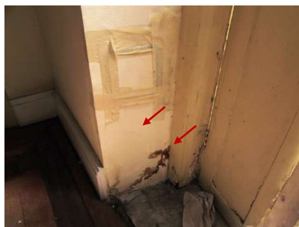
Figura 98 – Detalhe da parede com acúmulo de matéria orgânica
