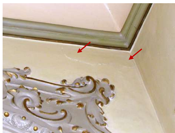
Figura 74 – Detalhe do desprendimento do substrato em zona sobre o acesso à sala de reunião
