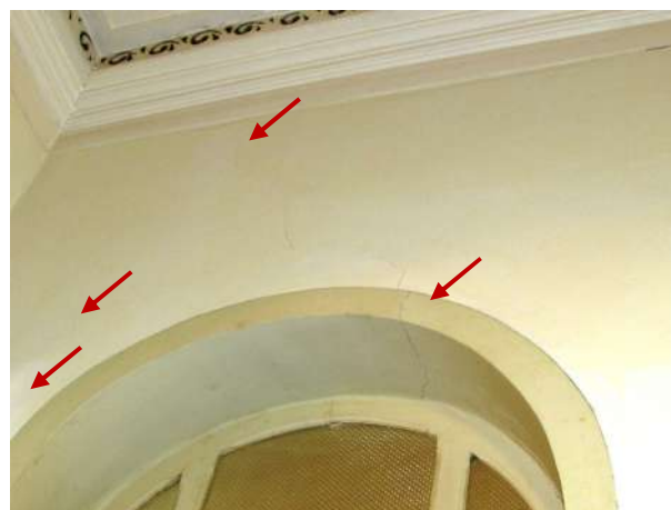
Figura 84 - Detalhe da parede oeste trincada (sobre o acesso à circulação)
