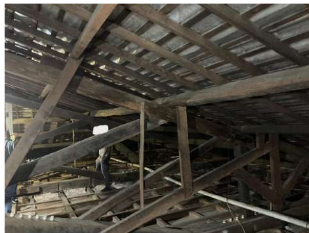
Figura 49 – Vista geral da estrutura da cobertura com percepção de configuração não padronizada
