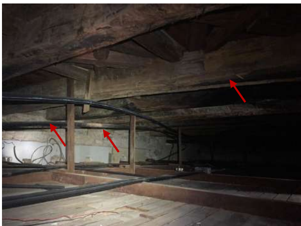
Figura 172 - Detalhe das vigas de madeira apoiadas na parede e eletrodutos fixados na madeira de suporte do piso superior
