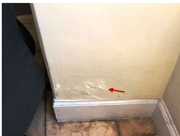
Figura 184 -Detalhe da parede com umidade e desprendimento do substrato e pintura
