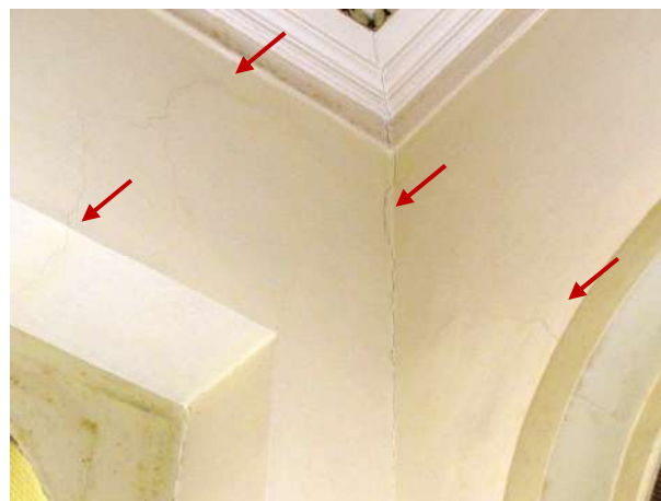
Figura 90 - Detalhe da parede trincada na interface ortogonal e sobre o acesso ao hall
