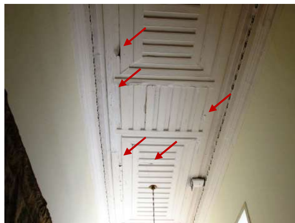
Figura 96 – Vista do forro com pontos danificados e desgastados
