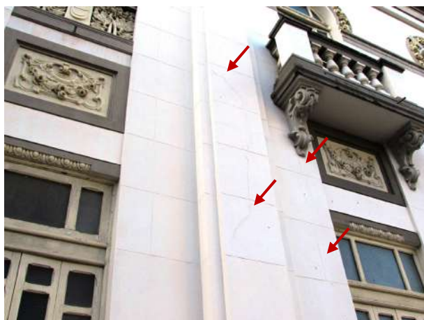
Figura 26 – Detalhe da fachada trincada na adjacência da mão francesa da sacada central
