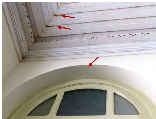
Figura 201 - Detalhe da parede, região sobre a porta, fissurada e forro mofado
