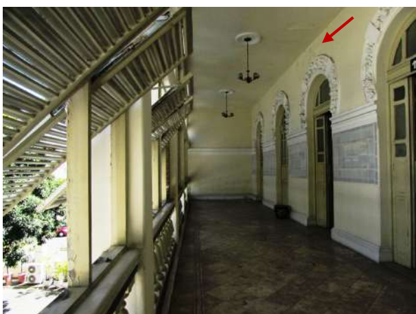
Figura 138 – Vista geral do terraço coberto com apontamento para infiltração sobre porta de acesso central
