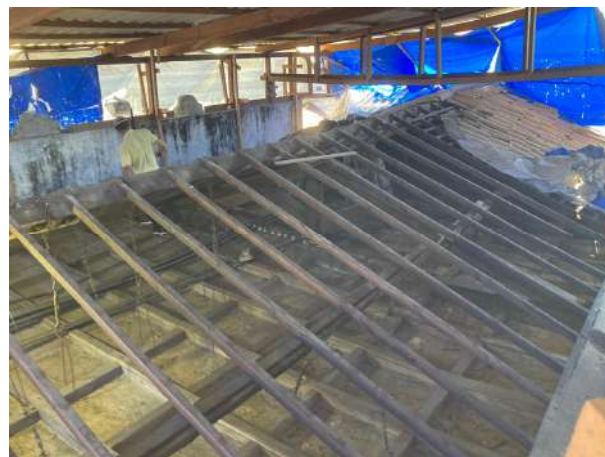
Figura 61 - Vista geral da condição atual da cobertura do ambiente salão de jantar
