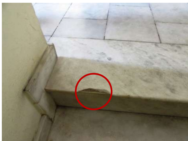
Figura 158 – Detalhe do mármore da escada danificado
