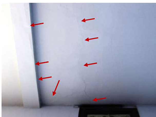
Figura 275 – Detalhe da laje superior da varanda trincada
