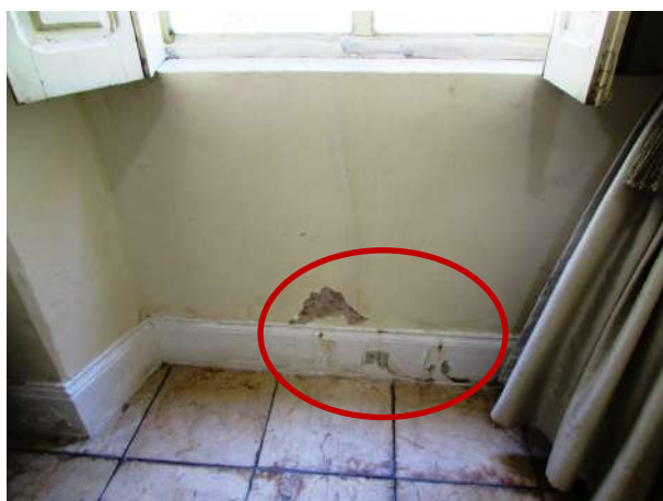
Figura 190 - Detalhe da parede com umidade e desprendimento do substrato e pintura
