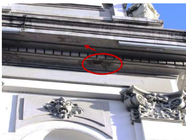
Figura 38 - Detalhe da moldura da marquise com perda do substrato (círculo) e zona de acúmulo de umidade (seta)
