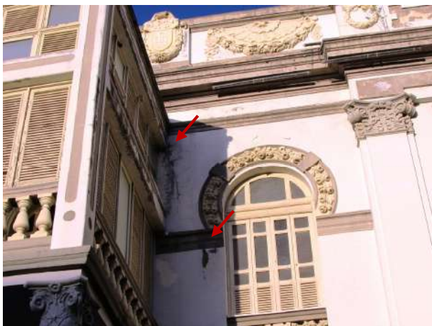
Figura 30 – Detalhe do acúmulo de umidade da parede ortogonal à fachada (terraço coberto)
