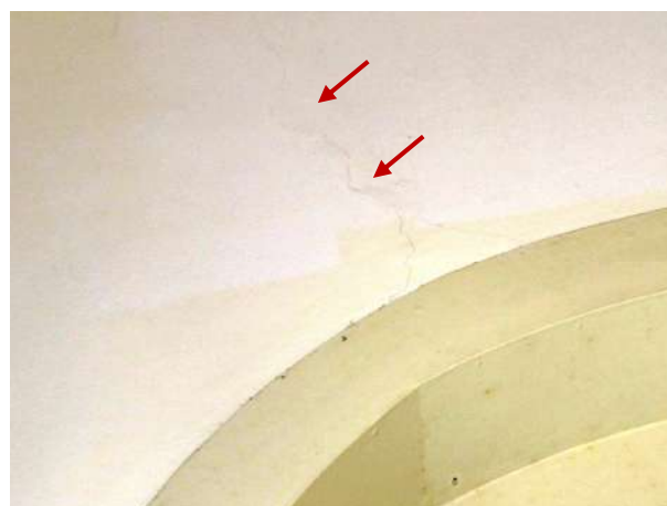
Figura 94 – Detalhe da parede, região sobre a porta, fissurada
