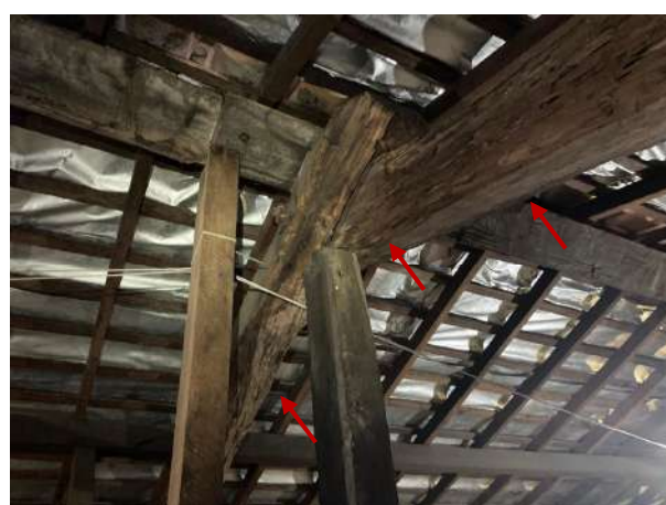
Figura 53 – Detalhe das tesouras degradadas, com perda considerável da seção resistente
