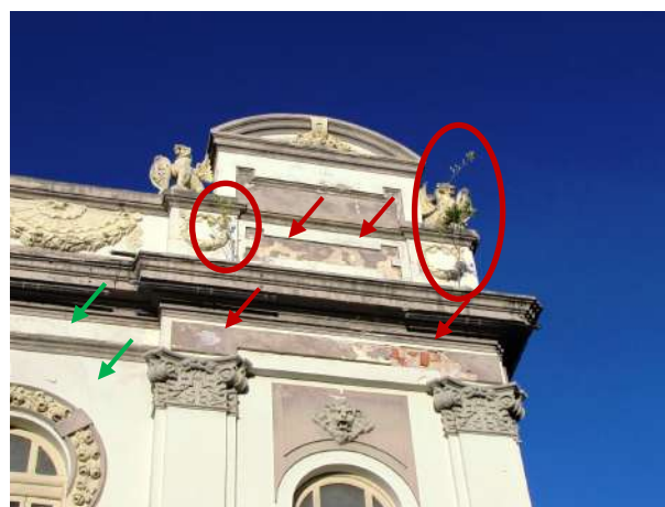
Figura 29 - Detalhe da platibanda e marquise com acúmulo de matéria orgânica (generalizado), crescimento de vegetação (círculos), desagregação do substrato (seta vermelha) e trinca (seta verde) na parte adjacente
