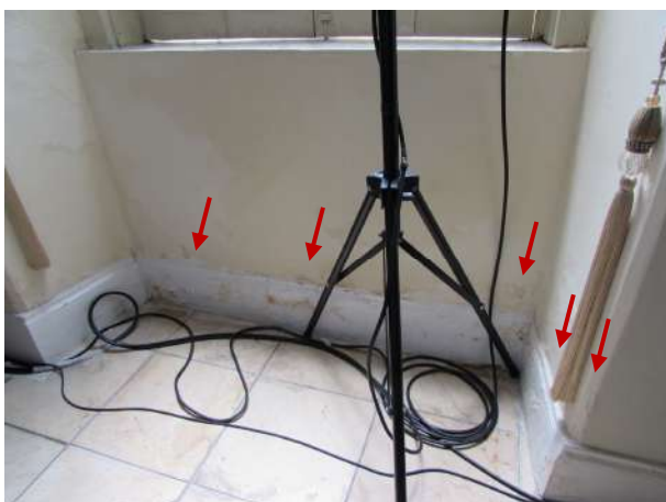
Figura 256 - Detalhe das manchas de infiltração/umidade ascendente na parede
