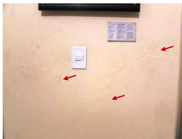
Figura 243 - Detalhe da parede com umidade e desprendimento do substrato e pintura (zona sob o retrato do atual governador)
