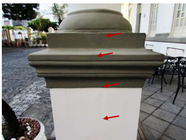
Figura 273 – Detalhe da coluna da varanda trincada
