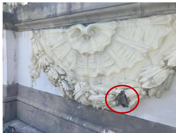
Figura 33 – Detalhe do ornato com perda parcial do substrato
