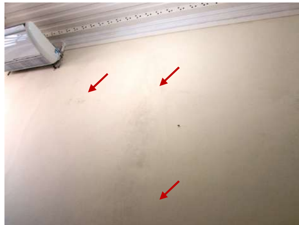
Figura 217 – Detalhe da parede oeste com presença de mofo
