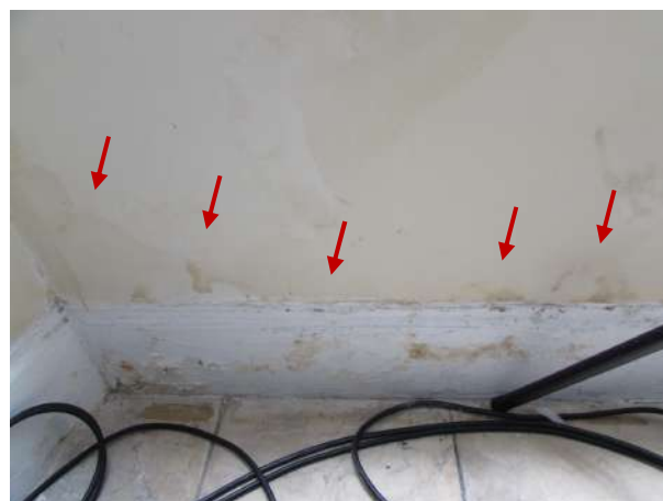
Figura 257 - Detalhe das manchas de infiltração/umidade ascendente na parede
