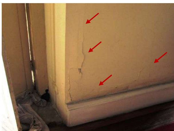
Figura 99 – Detalhe da parede com umidade, acúmulo de matéria orgânica e desprendimento do substrato e pintura
