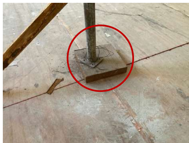
Figura 137 – Detalhe do berço do cimbramento
