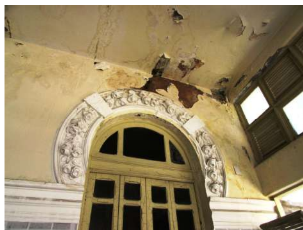
Figura 139 – Detalhe da parede com umidade, acúmulo de matéria orgânica e desprendimento do substrato e pintura
