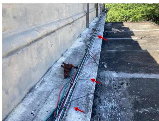
Figura 45 – Detalhe dos cabos dos circuitos de distribuição sobre o rufo
