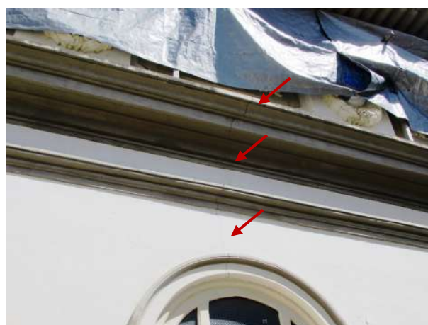
Figura 126 - Detalhe da parede, região sobre a porta, rachada
