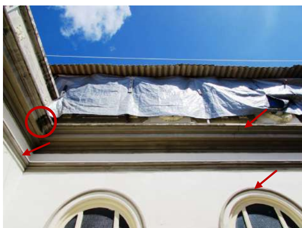
Figura 125 – Detalhe da moldura com acúmulo de matéria orgânica (círculo) e trincas nas paredes (setas)
