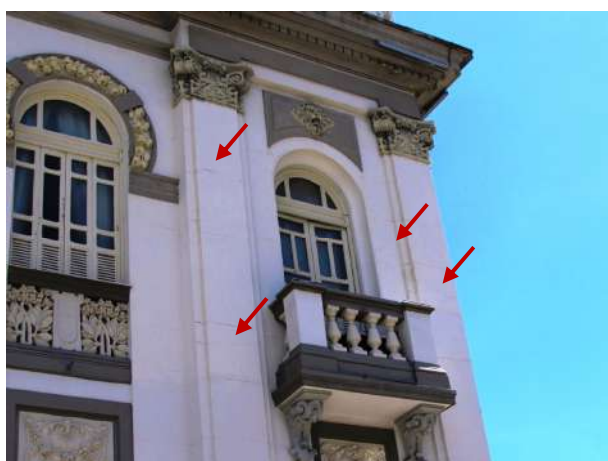
Figura 18 – Detalhe das trincas e fissuras no entorno da sacada leste próximo à fachada norte
