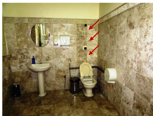
Figura 205 – Vista geral do lavabo do gabinete com destaque para revestimento substituído
