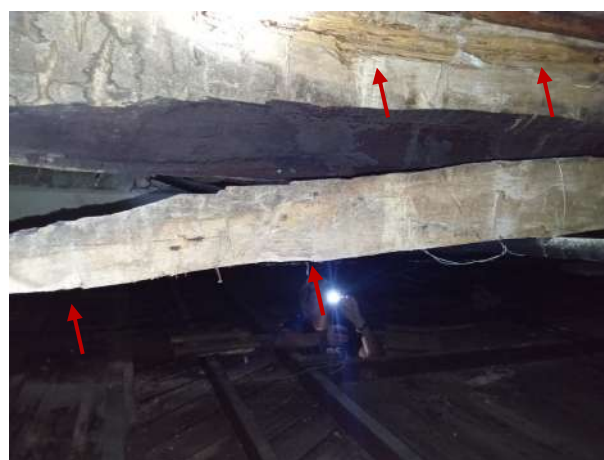
Figura 177 - Detalhe de viga deformada
