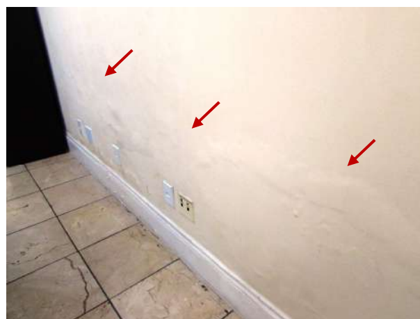
Figura 219 - Detalhe da parede com umidade e desprendimento do substrato e pintura
