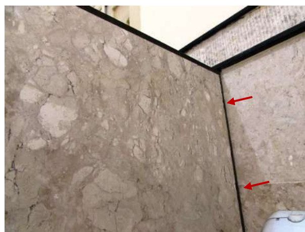
Figura 149 - Detalhe do chumbamento das divisórias de mármore em perfis de alumínio
