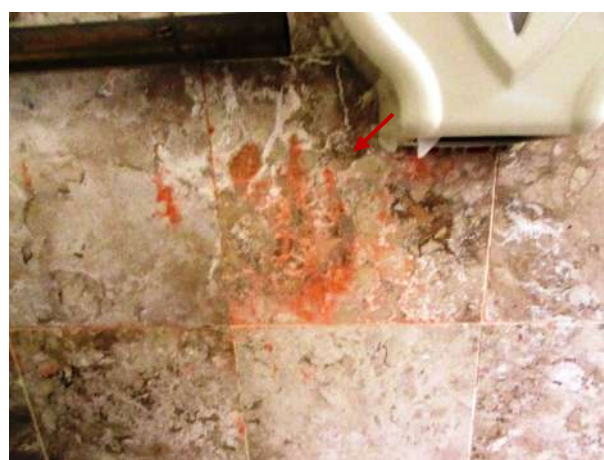
Figura 207 - Detalhe das pedras de mármore com lixiviação e produtos de óxidos de ferro
