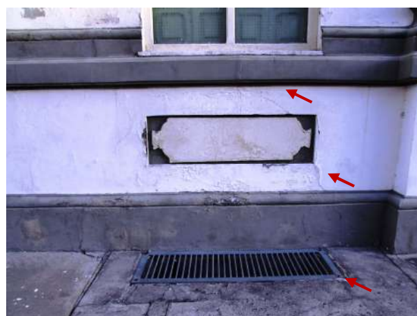
Figura 39 – Detalhe da umidade ascendente da zona da localização da grelha
