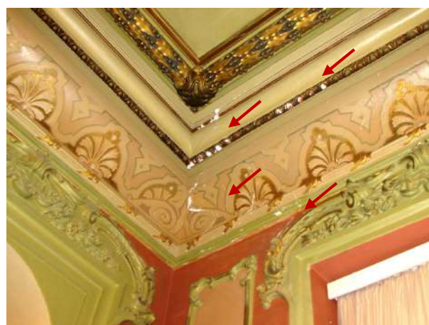
Figura 70 – Detalhe da pintura artística desgastada e danificada pontualmente
