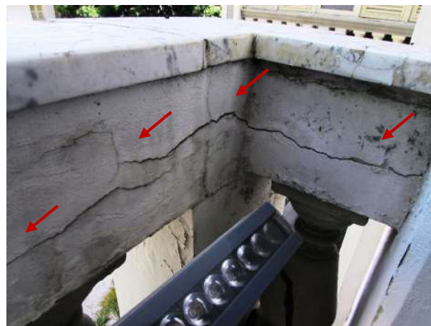
Figura 118 - Detalhe da sacada trincada e com manchas de umidade
