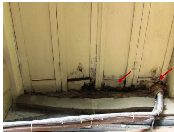
Figura 135 – Detalhe do acúmulo de umidade na zona inferior da porta e dreno do ar-condicionado transpassando a esquadria
