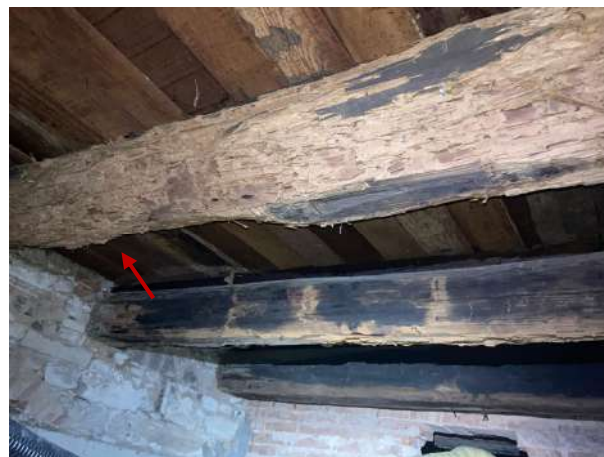
Figura 167 - Detalhe da viga de madeira do piso do pavimento superior degradada, com perda considerável da seção resistente
