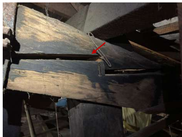
Figura 57 - Detalhe da tesoura com perda de contato e encaixe entre as peças
