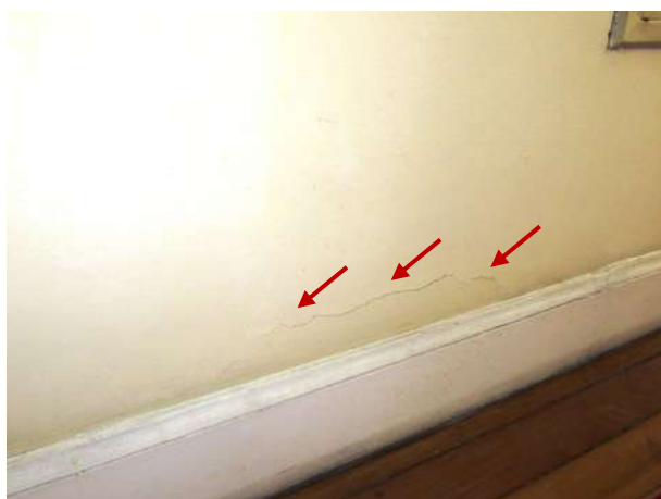
Figura 144 - Detalhe da trinca na zona inferior da parede
