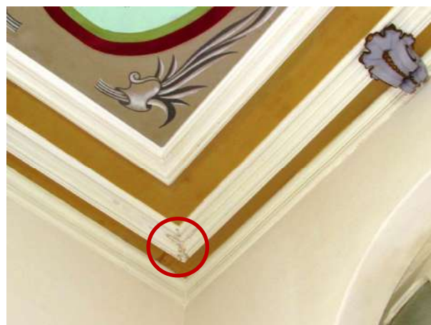
Figura 237 – Detalhe da mancha de umidade no forro com pintura artística
