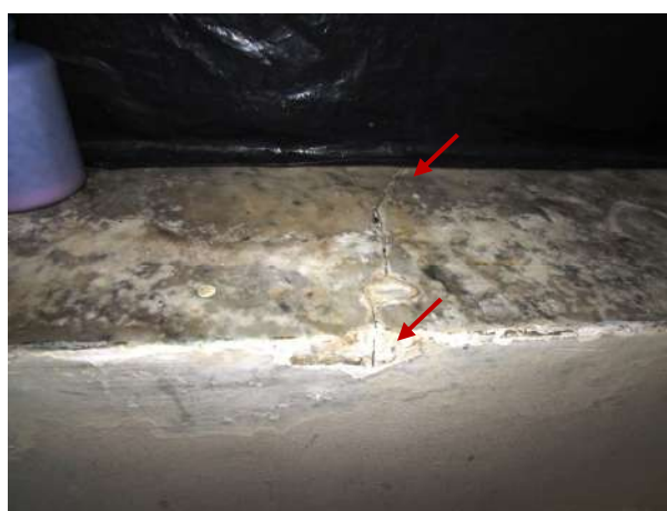
Figura 224 – Detalhe do peitoril trincado
