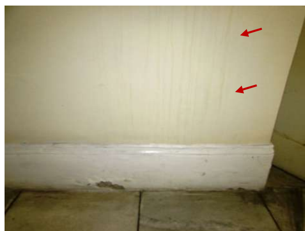
Figura 253 – Detalhe das manchas de infiltração na parede adjacente ao salão multifuncional
