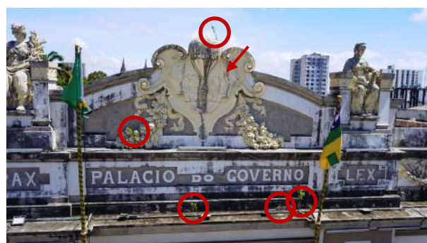
Figura 13 - Detalhe da platibanda e marquise com acúmulo de matéria orgânica (generalizado) e crescimento de vegetação (círculos) e apontamento para produto de corrosão no Brasão
