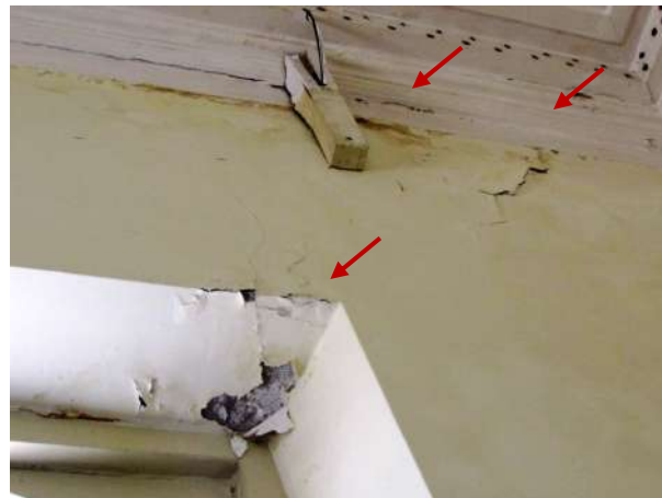
Figura 112 - Detalhe da parede com umidade, acúmulo de matéria orgânica e desprendimento do substrato e pintura
