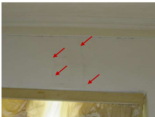
Figura 83 - Detalhe da parede norte trincada (sobre a janela)
