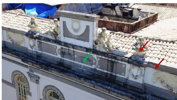
Figura 24 - Detalhe da platibanda e marquise com acúmulo de matéria orgânica (generalizado), zonas trincadas (seta vermelha) e desprendimento do substrato (seta verde)
