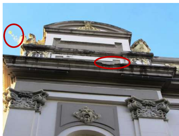
Figura 23 - Detalhe da platibanda e marquise com acúmulo de matéria orgânica (generalizado) e destaque para vegetação e fração da moldura da marquise danificada
