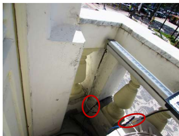
Figura 68 – Condutores aparentes e derivações elétricas sem isolamento
