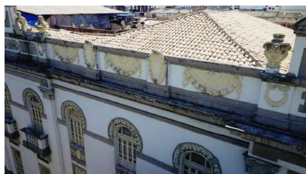
Figura 25 - Detalhe da platibanda e marquise com acúmulo de matéria orgânica (generalizado)
