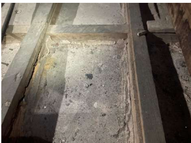
Figura 64 – Detalhe da estrutura de madeira do forro de gesso do salão de jantar
