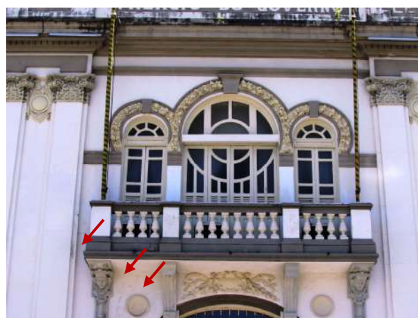
Figura 19 – Vista da sacada central com apontamento para manchas de umidade adjacentes
