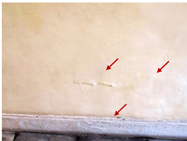
Figura 210 - Detalhe da parede com umidade e desprendimento do substrato e pintura
