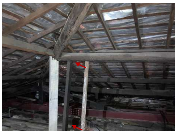
Figura 50 – Detalhe dos apoios da cobertura deformados
