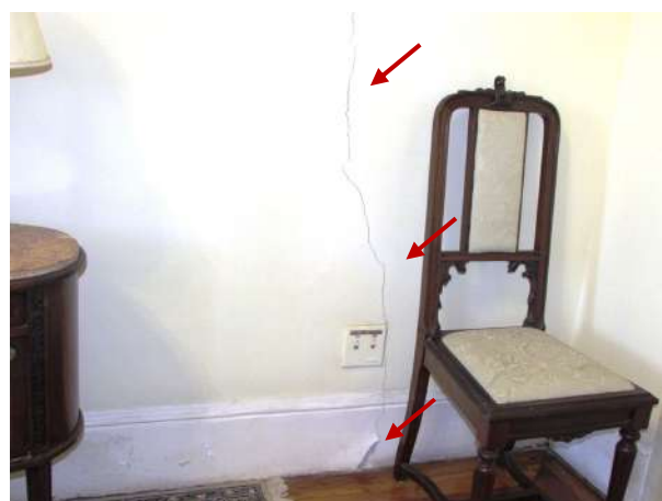
Figura 108 – Detalhe da trinca na parede oeste do quarto do governador
