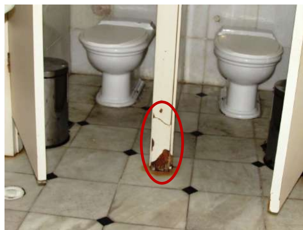
Figura 213 – Detalhe da divisória de madeira banheiro feminino danificada
