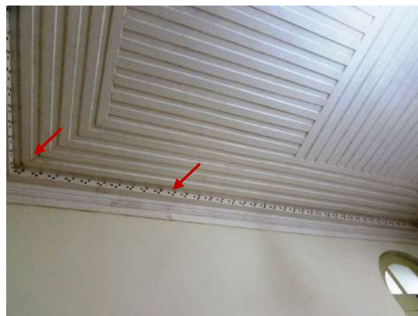
Figura 203 – Detalhe do forro com pintura desgastada e zonas mofadas
