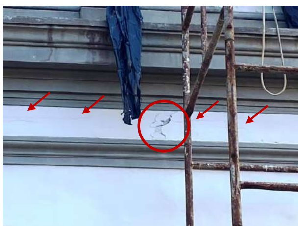
Figura 127 – Detalhe da parede norte com trincas horizontais e região de desprendimento do substrato
