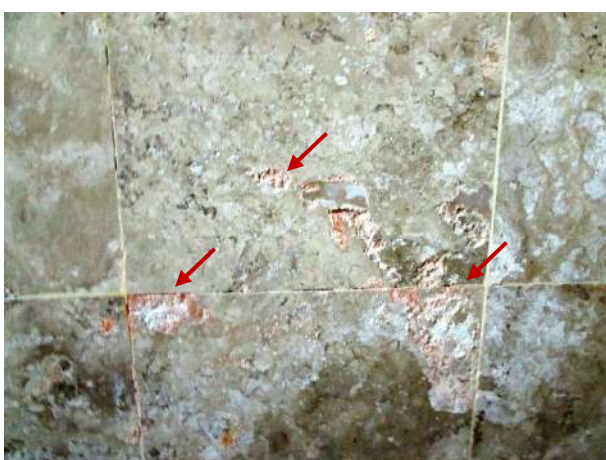
Figura 206 – Detalhe das pedras de mármore com lixiviação e produtos de óxidos de ferro
