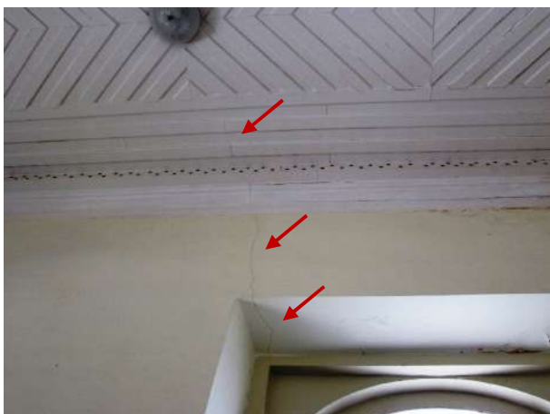
Figura 113 - Detalhe da parede, região sobre a porta, fissurada
