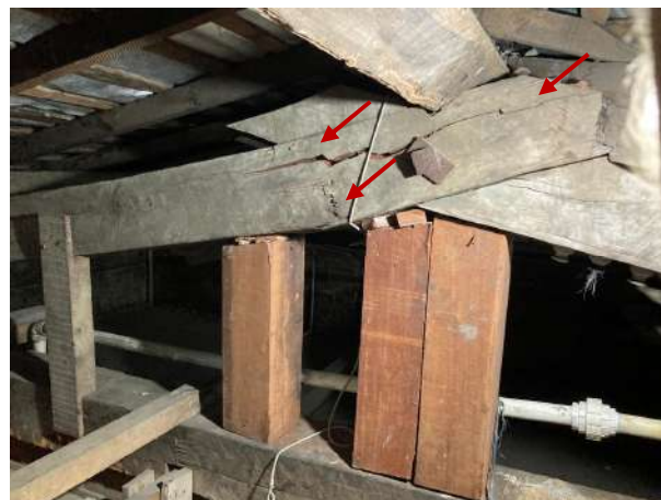
Figura 55 - Detalhe da tesoura rompida, apesar do gancho de reforço
