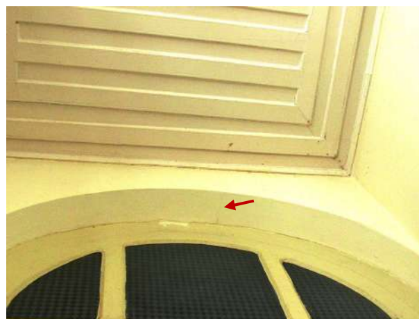
Figura 266 - Detalhe da parede, região sobre a porta, fissurada
