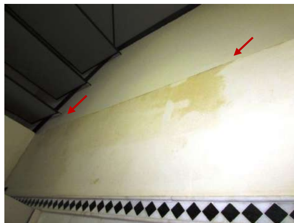
Figura 215 – Detalhe da parede oeste com manchas de umidade no banheiro masculino
