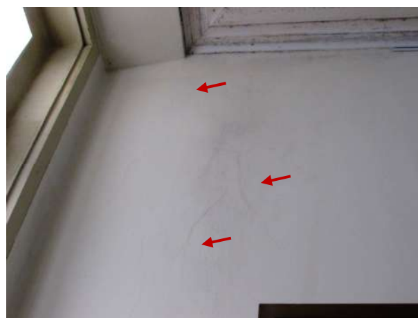
Figura 262 - Detalhe da zona superior da parede norte com trincas mapeadas
