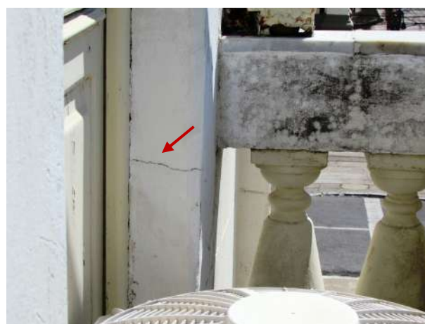
Figura 76 – Detalhe da parede trincada na sacada
