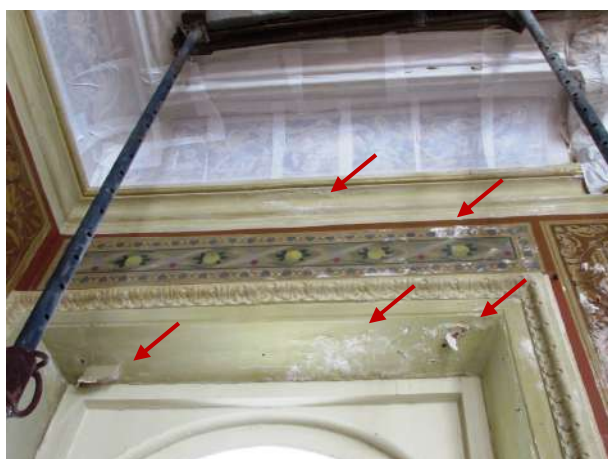
Figura 132 – Detalhe da pintura artística das paredes danificadas e desgastada pontualmente
