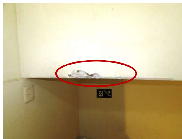
Figura 159 – Detalhe do substrato desprendido na escada
