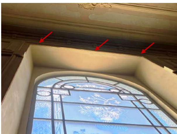
Figura 121 - Detalhe da parede, região sobre a janela, com infiltração
