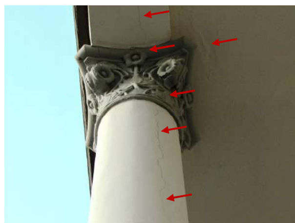
Figura 274 – Detalhe da coluna da varanda trincada, com extensão até a laje
