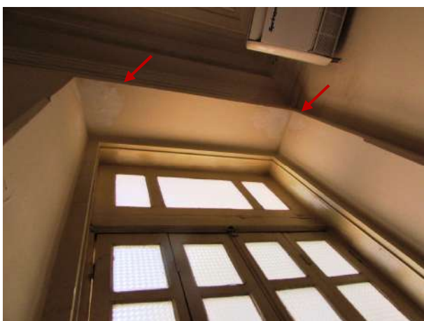
Figura 218 – Detalhe do entorno da janela com mancha de umidade na zona superior
