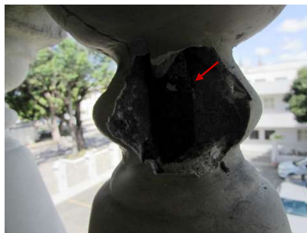
Figura 141 - Detalhe do ferro da balaustrada com corrosão e consequente deslocamento do substrato
