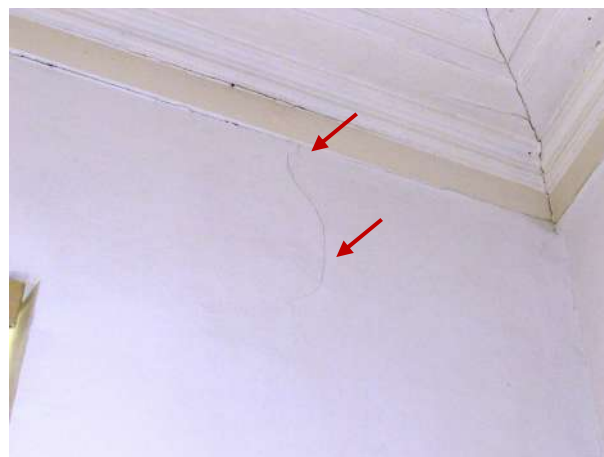
Figura 82 – Detalhe da parede norte trincada
