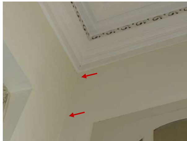
Figura 153 - Detalhe da parede trincada
