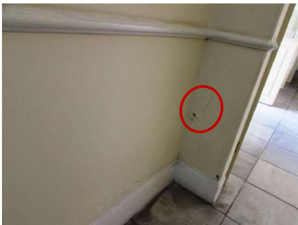
Figura 248 – Detalhe da zona inferior da parede com desprendimento do substrato e trincas
