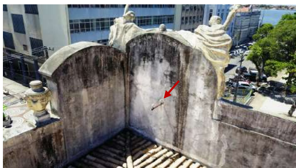
Figura 16 – Detalhe da platibanda com acúmulo de matéria orgânica (generalizado) e apontamento para o terminal de captação (SPDA)
