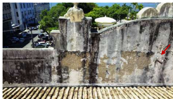
Figura 17 - Detalhe da platibanda com acúmulo de matéria orgânica (generalizado) e apontamento para o terminal de captação (SPDA)
