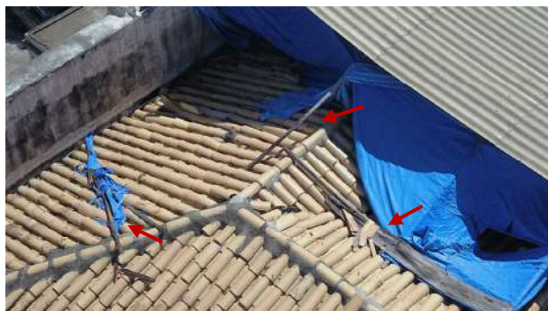
Figura 42 – Detalhe da estrutura auxiliar da cobertura temporária danificada
