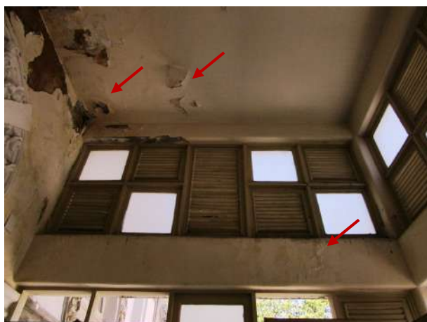
Figura 140 - Detalhe da parede e laje com umidade, acúmulo de matéria orgânica e desprendimento do substrato e pintura
