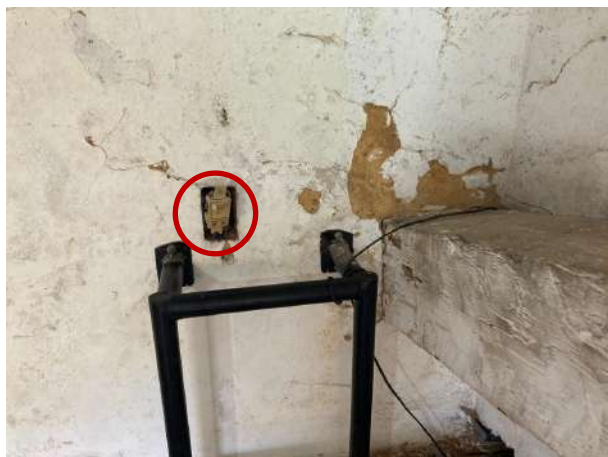
Figura 48 – Detalhe da caixa do interruptor com tampa danificada, localizada imediatamente acima da escada de acesso à casa de máquinas
