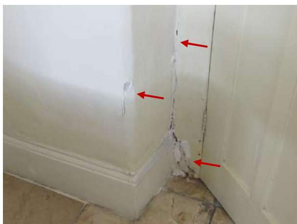
Figura 196 - Detalhe da parede trinca e com desprendimento do substrato
