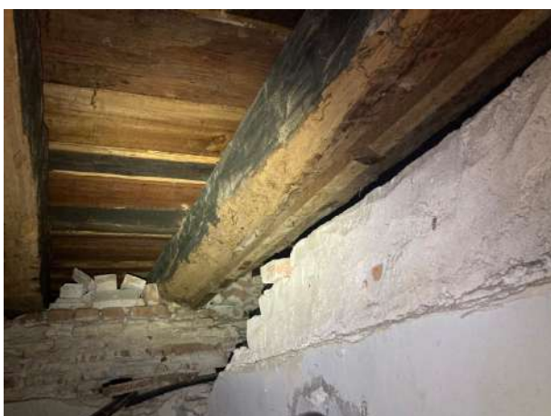
Figura 168 – Detalhe da viga de madeira apoiada na parede
