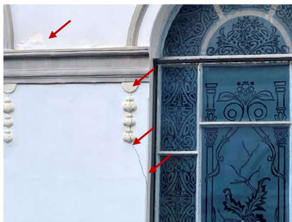
Figura 129 – Detalhe do entorno da janela da escada principal (face externa) com trinca e descascamento da pintura
