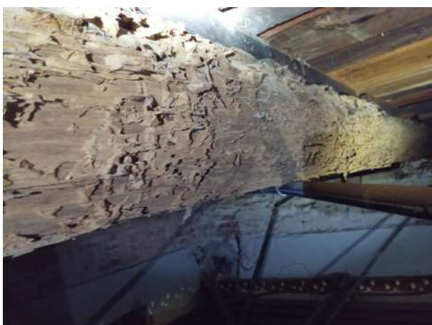
Figura 170 - Detalhe da viga de madeira do piso do pavimento superior degradada, com perda considerável da seção resistente
