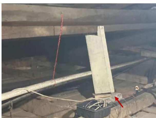
Figura 52 – Detalhe da solução paliativa entre o apoio e o berço
