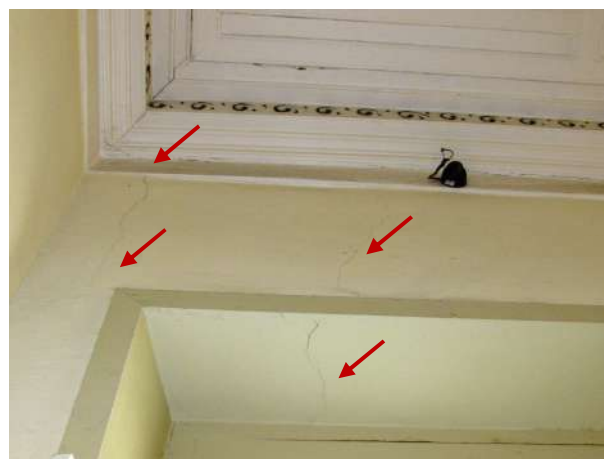
Figura 143 - Detalhe da parede, região sobre a porta, trincada
