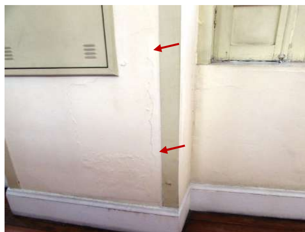
Figura 145 - Detalhe da parede com umidade e desprendimento do substrato e pintura
