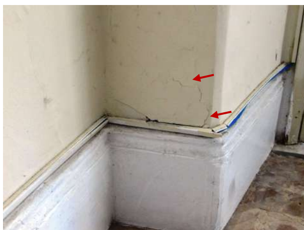
Figura 261 – Detalhe do desprendimento do substrato na zona inferior da parede sul
