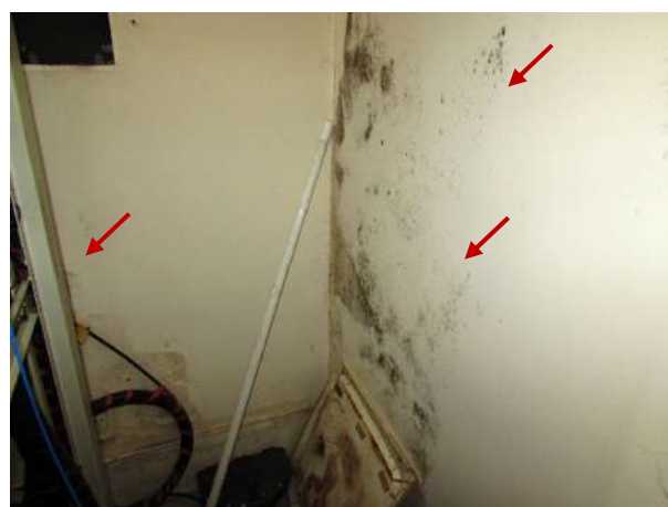
Figura 223 - Detalhe da parede leste e sul com presença de mofo
