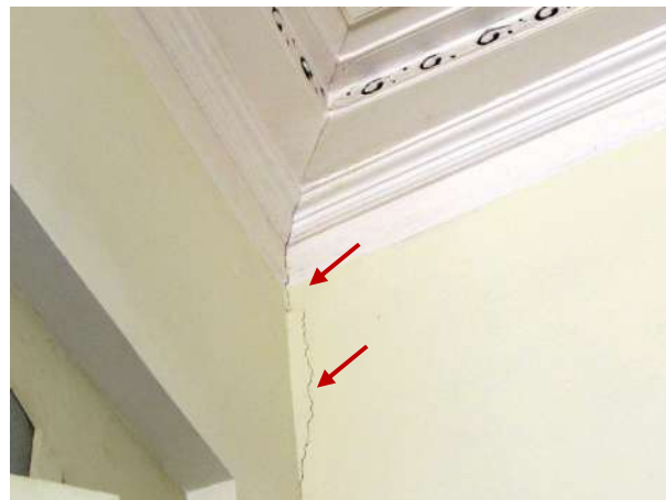
Figura 102 - Detalhe da parede trincada na interface ortogonal
