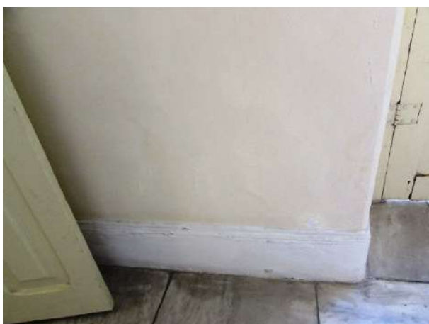
Figura 250 - Detalhe da parede com umidade e desprendimento do substrato e pintura
