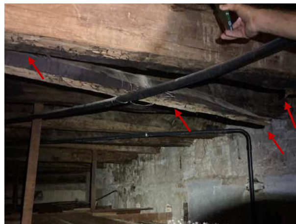
Figura 173 - Detalhe da peça de madeira com a seção rompida e eletroduto fixado na fração desprendida
