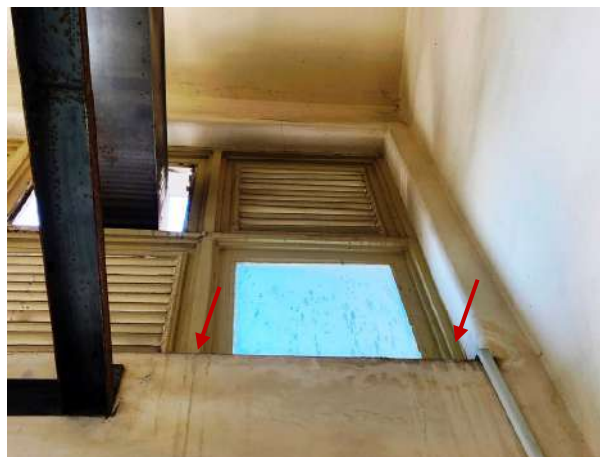
Figura 165 – Detalhe da parede do apoio com infiltração pela esquadria norte
