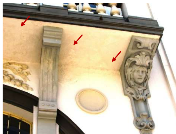
Figura 21 - Detalhe das manchas de umidade sob a laje da sacada central
