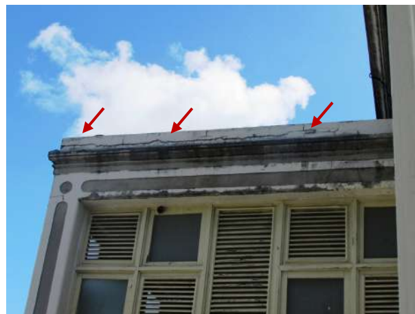
Figura 31 -Detalhe da trinca perimetral na laje superior do terraço coberto
