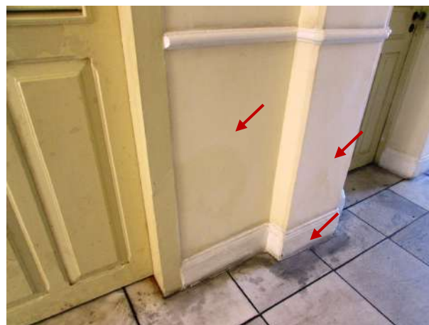
Figura 211 – Detalhe das manchas de umidade na parede adjacente aos banheiros
