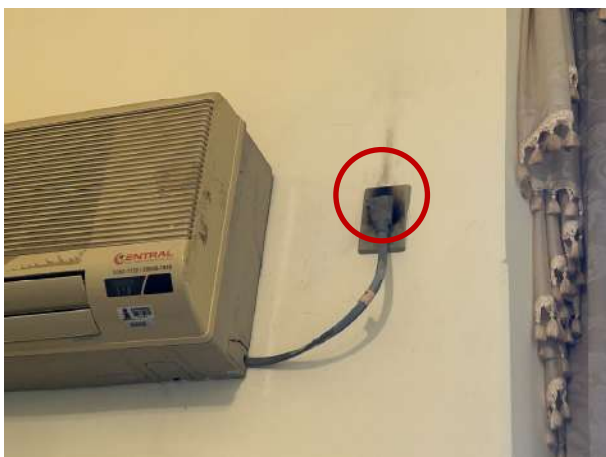
Figura 103 – Detalhe da tomada com evidência de curto-circuito ocorrido e já corrigido
