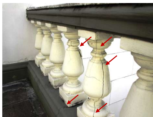
Figura 128 -Detalhe das balaustradas trincadas
