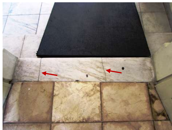
Figura 187 - Detalhe da soleira trincada
