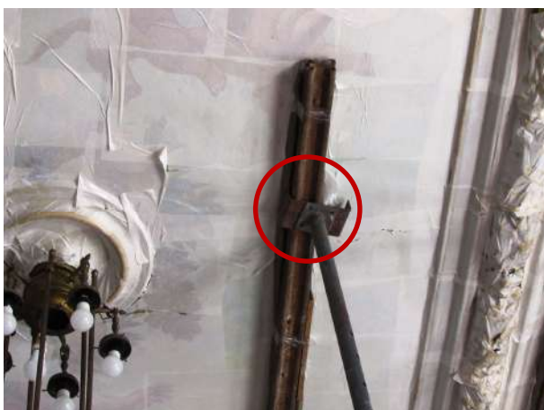
Figura 136 – Detalhe do cabeçote deslocado
