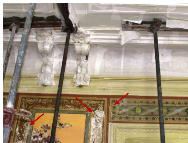
Figura 133 - Detalhe da pintura artística danificada pontualmente e trinca no vértice da porta
