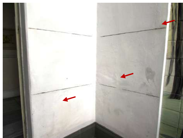
Figura 234 - Detalhe da parede com umidade e desprendimento do substrato e pintura
