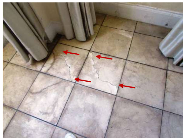
Figura 181 – Detalhe do piso de mármore trincado
