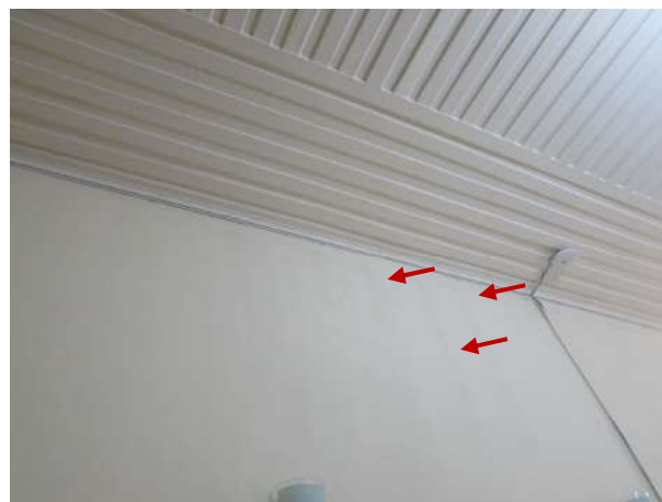
Figura 260 – Detalhe da mancha de infiltração na zona superior da parede sul
