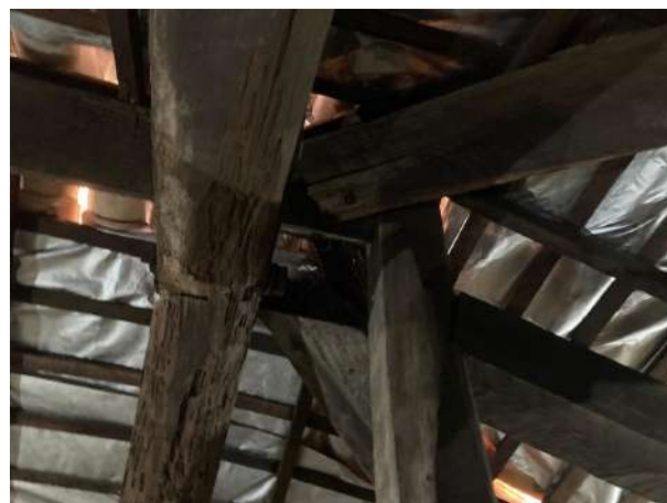
Figura 63 – Detalhe da tesoura degradada, com perda considerável da seção resistente, manta em condição normal de uso
