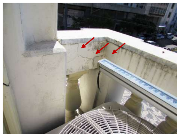
Figura 80 - Detalhe da sacada leste fissurada
