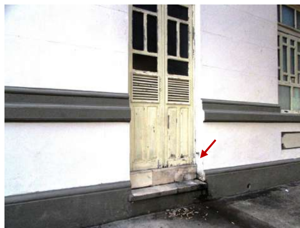
Figura 27 – Detalhe do acúmulo de umidade na zona inferior da porta que dá acesso à sala de espera 2
