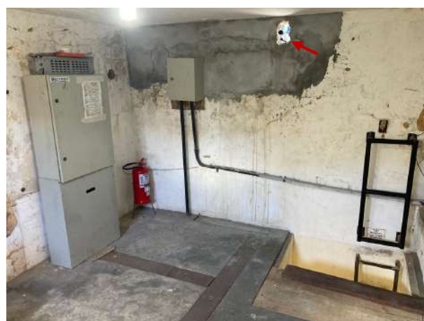
Figura 47 – Vista da casa de máquinas com apontamento para abertura na parede e percepção de pintura desgastada
