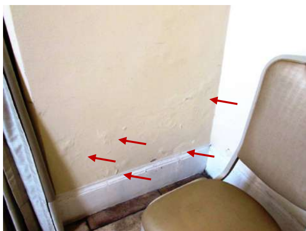
Figura 182 -Detalhe da parede com umidade e desprendimento do substrato e pintura
