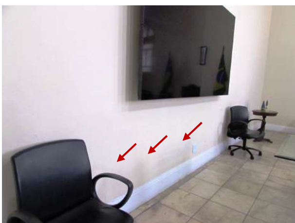
Figura 204 – Detalhe da parede norte onde foi constatado som cavo e perda de aderência do substrato
