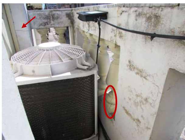
Figura 75 – Detalhe da balaustrada trincada e trinca na parede da sacada
