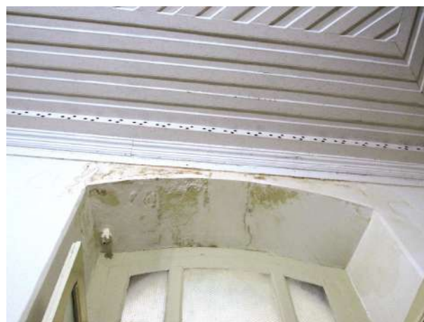
Figura 239 – Detalhe do arco da porta de acesso entre a galeria de artes e sala cidade de Aracaju com manchas de umidade generalizada e matéria orgânica
