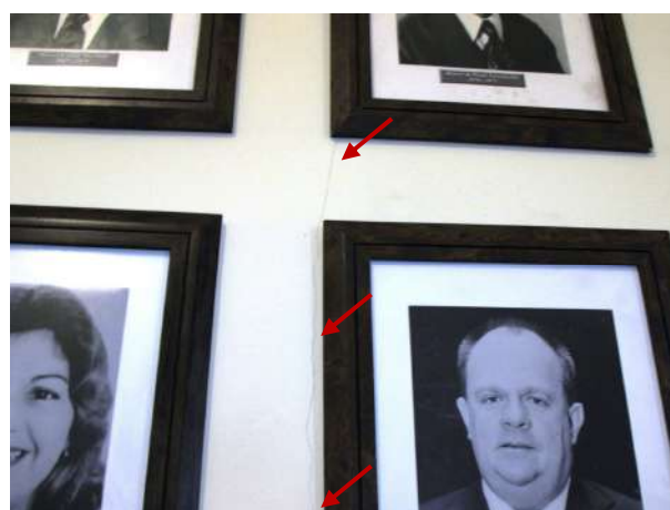
Figura 88 - Detalhe na parede de exposição dos retratados dos vice-governadores trincada
