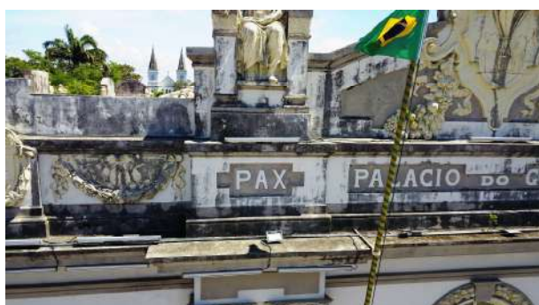
Figura 14 - Detalhe da platibanda e marquise com acúmulo de matéria orgânica (generalizado)
