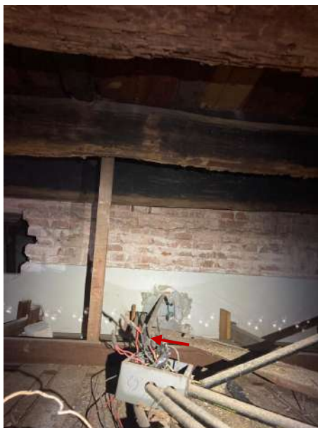
Figura 178 – Detalhe das vigas com perda de seção e circuitos elétricos aparentes, sobre forro de madeira
