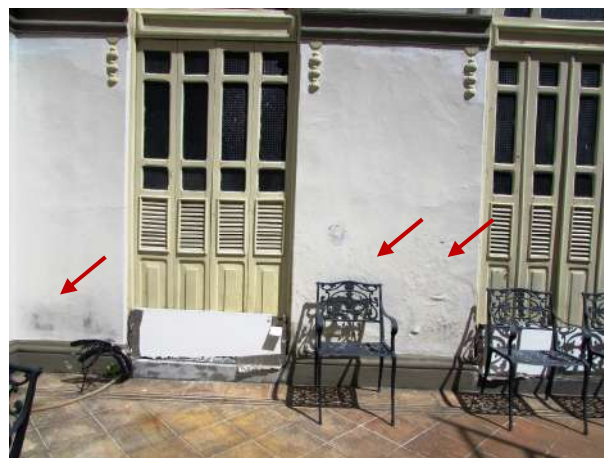
Figura 124 - Detalhe da parede com incidência de umidade e desprendimento do substrato e pintura
