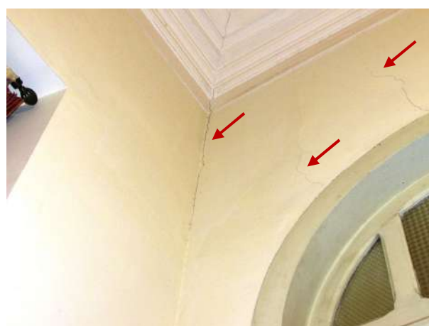
Figura 86 - Detalhe da parede trincada na interface ortogonal e sobre o acesso ao gabinete
