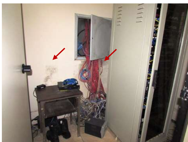
Figura 222 - Detalhe da parede leste com presença de mofo e cabos de rede emaranhados
