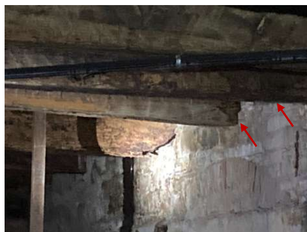
Figura 171 - Detalhe das vigas de madeira apoiadas na parede
