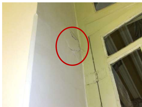
Figura 251 - Detalhe da zona adjacente à porta com desprendimento do substrato
