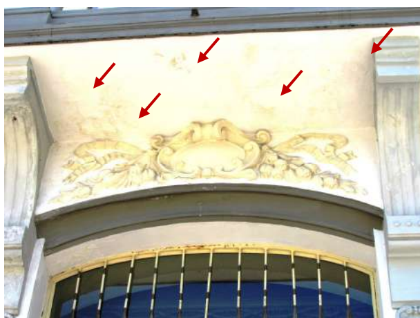
Figura 20 – Detalhe das manchas de umidade sob a laje da sacada central
