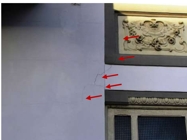
Figura 269 – Detalhe da parede, na zona acima do abrigo, trincada
