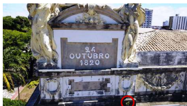
Figura 15 - Detalhe da platibanda e marquise com acúmulo de matéria orgânica (generalizado) e crescimento de vegetação (círculo)
