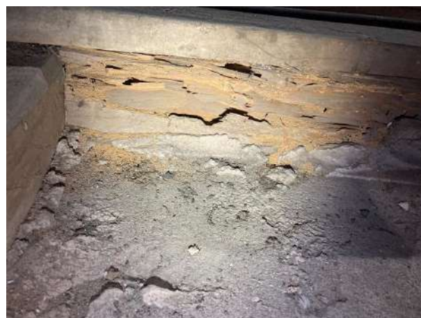
Figura 65 - Detalhe da estrutura do forro de gesso em estado avançado de degradação
