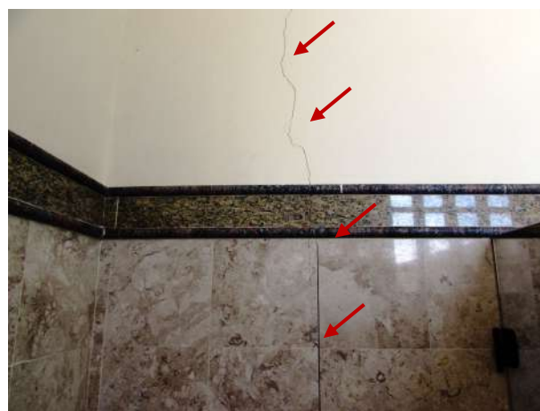
Figura 116 – Detalhe da trinca vertical na parede leste do banheiro
