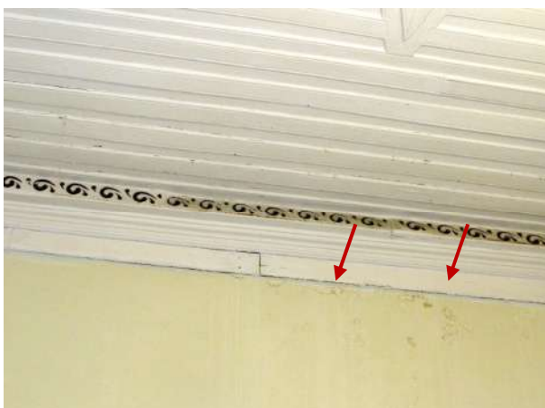
Figura 154 – Detalhe das manchas de umidade na parede sul do quarto
