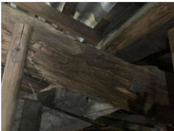
Figura 54 - Detalhe das tesouras degradadas, com perda considerável da seção resistente
