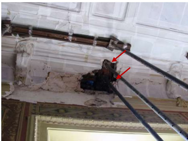
Figura 134 – Detalhe da zona do forro danificada
