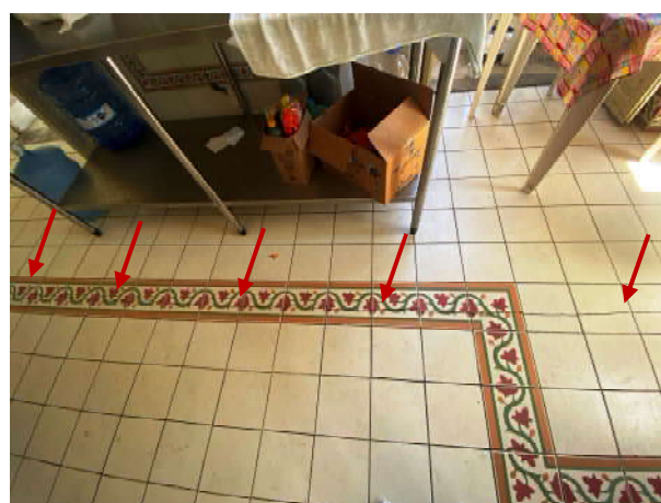
Figura 161 – Detalhe da rachadura no piso da cozinha
