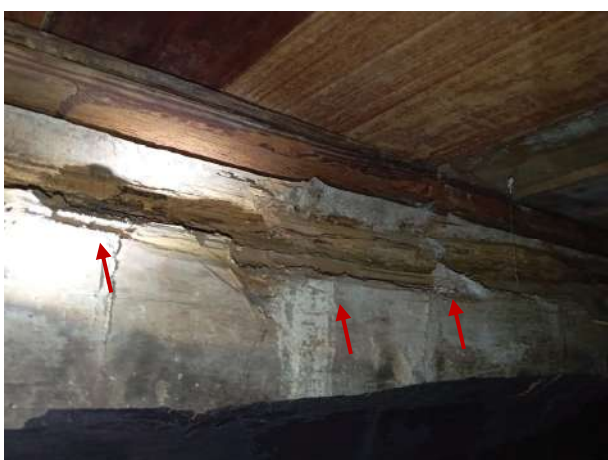
Figura 176 - Detalhe da madeira com perda com perda considerável da seção resistente
