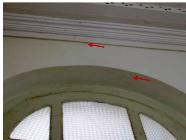
Figura 193 - Detalhe da parede fissurada
