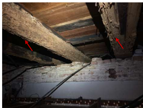
Figura 169 - Detalhe das vigas de madeira degradadas, tanto nas cabeceiras quanto no meio do vão, com perda considerável das seções
