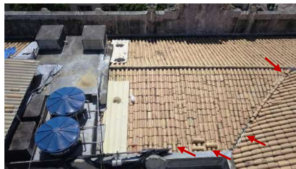
Figura 43 – Detalhe do telhado com telhas deslocadas, faltante e danificadas
