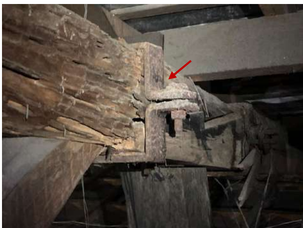
Figura 56 - Detalhe das tesouras degradadas, com perda considerável da seção resistente, apesar da braçadeira de reforço
