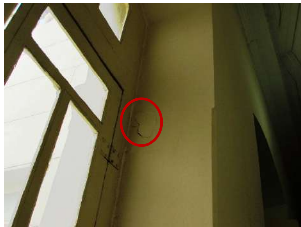
Figura 249 – Detalhe da zona adjacente à porta com desprendimento do substrato
