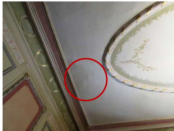
Figura 78 – Incidência de umidade no forro
