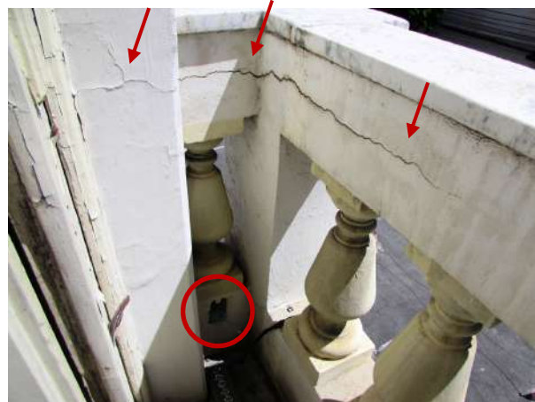
Figura 155 - Detalhe da sacada trincada e caixa de passagem elétrica sem tampa
