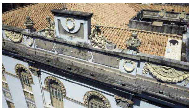
Figura 36 - Detalhe da platibanda e marquise com acúmulo de matéria orgânica (generalizado)
