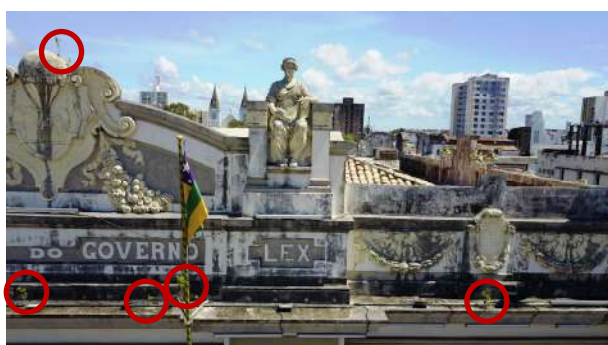
Figura 12 - Detalhe da platibanda e marquise com acúmulo de matéria orgânica (generalizado) e crescimento de vegetação (círculos)
