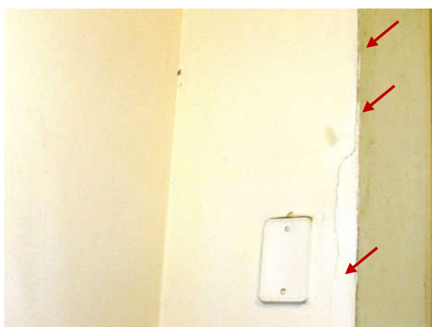
Figura 87 - Detalhe da trinca adjacente à caixa de instalação elétrica
