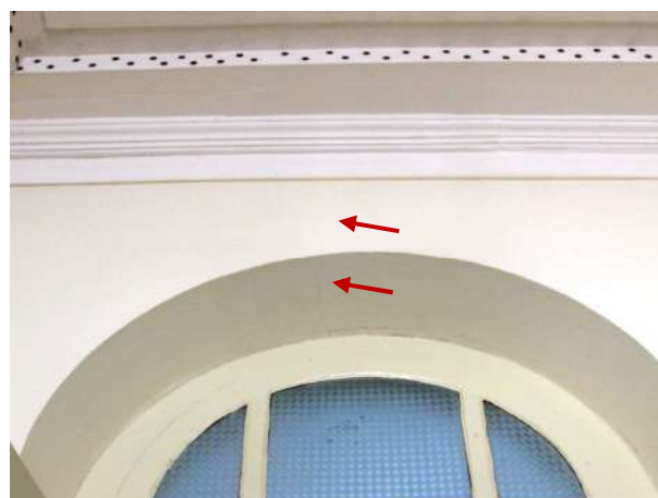
Figura 195 - Detalhe da parede, região sobre a porta, fissurada
